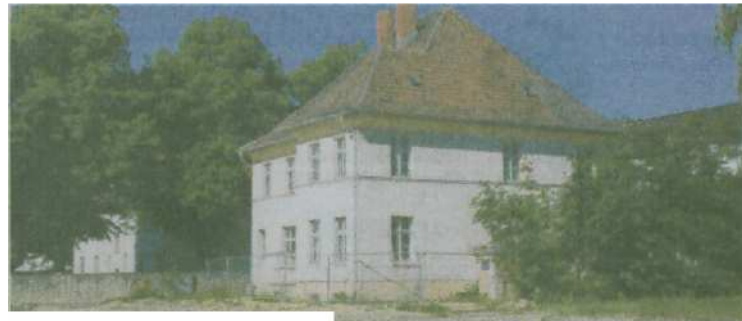
Die unter Denkmalschutz stehende Villa wird saniert.
